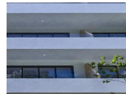
D Pintura Blanca Fachada
